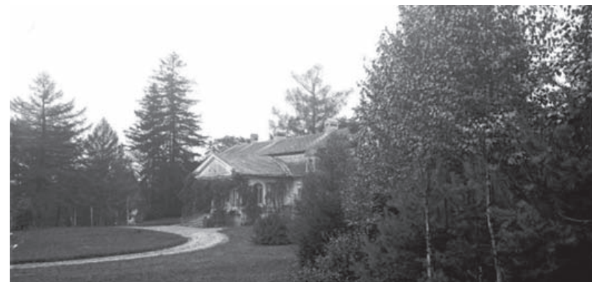
Dwór Konopków w Mogilanach w otoczeniu parkowym z 1928 roku
